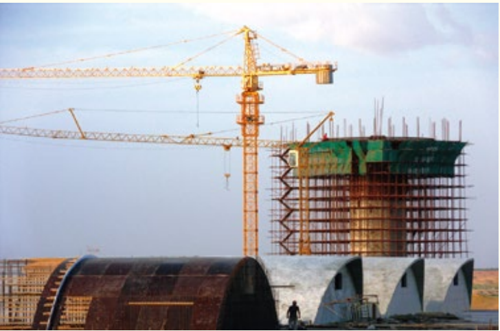
施工中的水塔、蓄水池 برج المياه وخزانها المياه تحت الإنشاء
