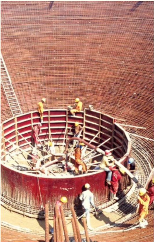
水塔施工现场
