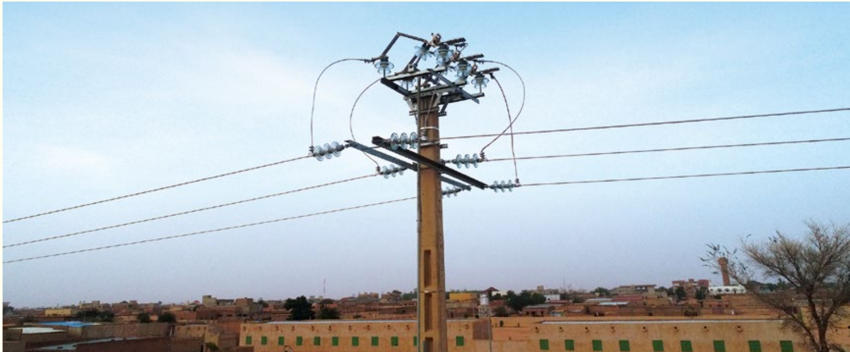
尼日尔多索和提拉贝里地区中低压电网增强项目
