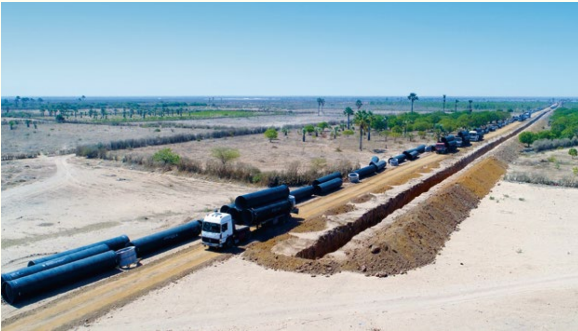
塞内加尔KMS3–LOT6项目：55公里球墨铸铁管线供货和铺设
