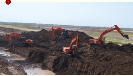
① 曝气池土方开挖 حفر حوض التهوية
