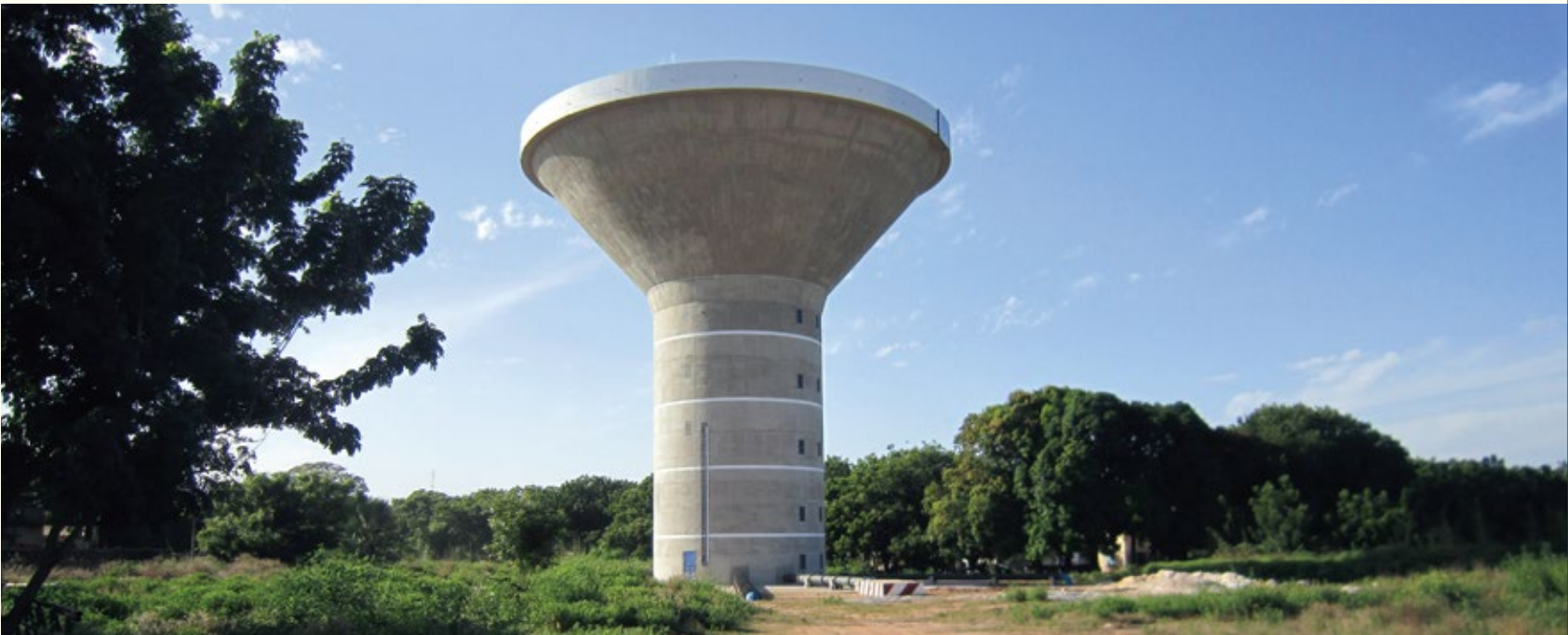
塞内加尔ZIGUINCHOR城市加压输水管道及3200方水塔工程
