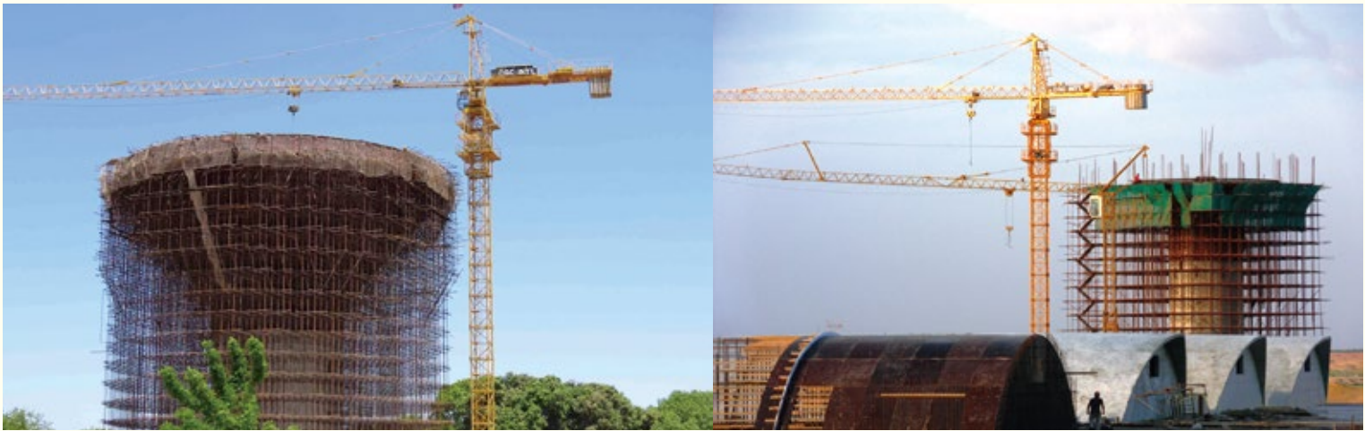
塞内加尔Ziguinchor省3200立方米大型水塔项目 مشروع برج المياه بحجم 3,200 متر مكعب في زيجينشور بالسنتغال
