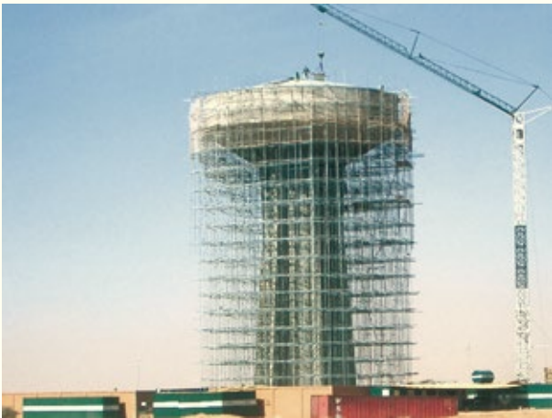
尼日尔Agadez水塔修建项目 – 1600立方米
