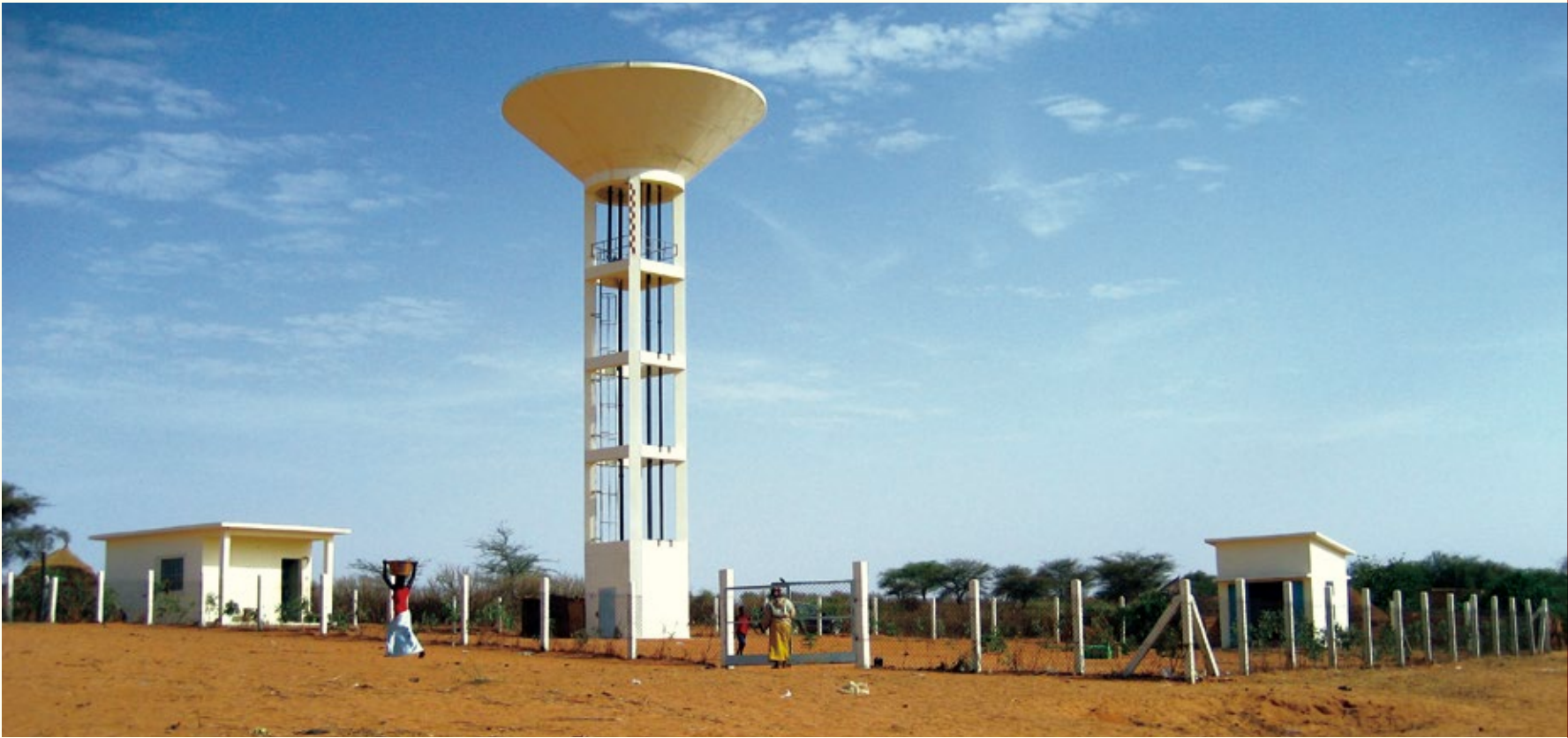
塞内加尔Kolda和Ziguinchor地区乡村供水系统与水塔建造项目
