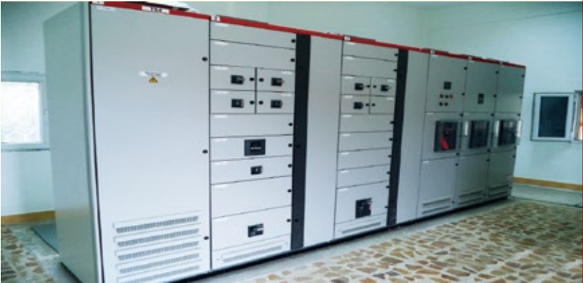
伊拉克阿玛拉污水处理厂三期项目中的电控系统 نظام التحكم الكهربائي لمشروع مجاري العمارة - المرحلة 3 في العراق
