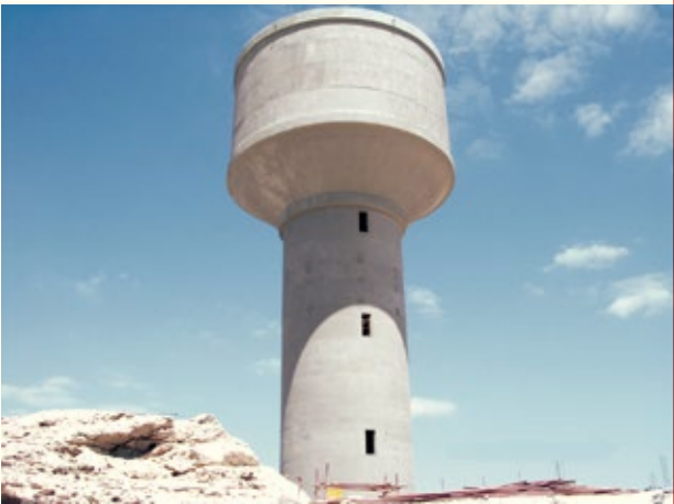
毛里塔尼亚Nouadhibou城市供水项目
