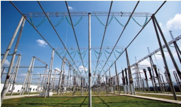
井冈山至瑞金220KV输电线路工程 (线路长度128km) مشروع خطوط نقل الطاقة الكهربائية 220 كف من مدينة جينغفانغشان إلى مدينة رويجين بالصين (طول الخط 128 كم)
